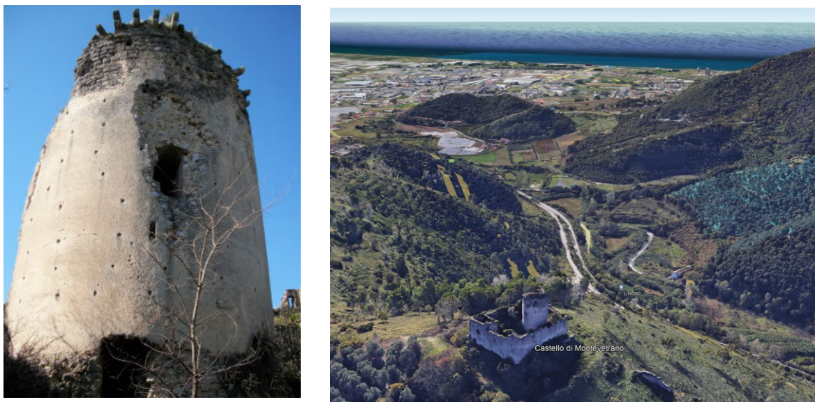
Fig.24 | Castello di Montevetrano – foto ripresa dal Sito ufficiale del Comune – foto googleearth
